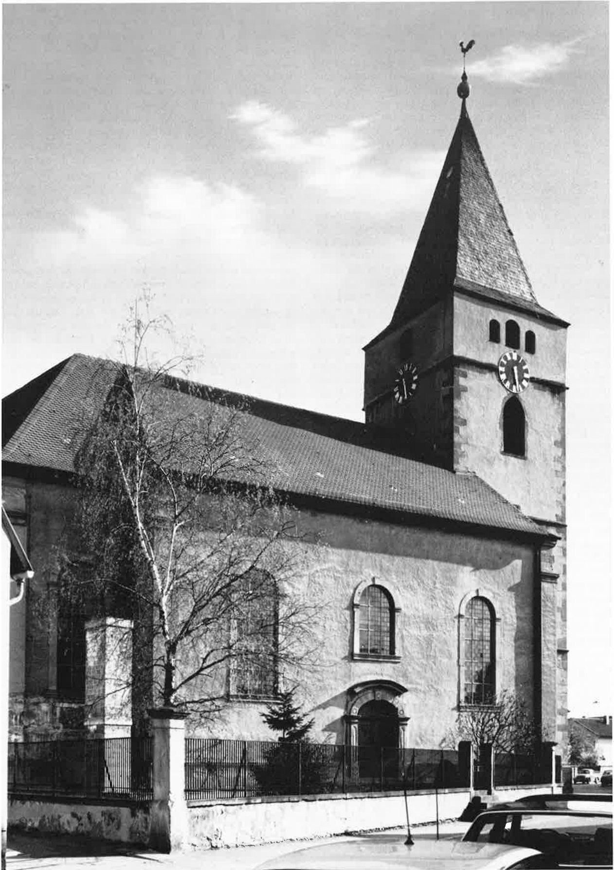
Ansicht der Kirche von Nordosten
